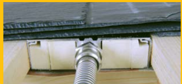
Solvarme-panelerne monteres i hulrummet mellem undertag og naturskifertag.
